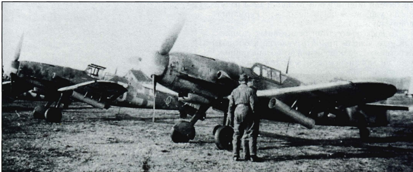
Специально для перехвата тяжелых бомбардировщиков под крыло Bf 109 подвешивали реактивные снаряды. Скорости они не прибавляли, да и управлять самолетом было намного сложнее...
